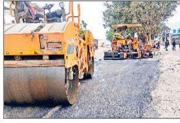
सोनीपत। सड़क का चल रहा निर्माण।
